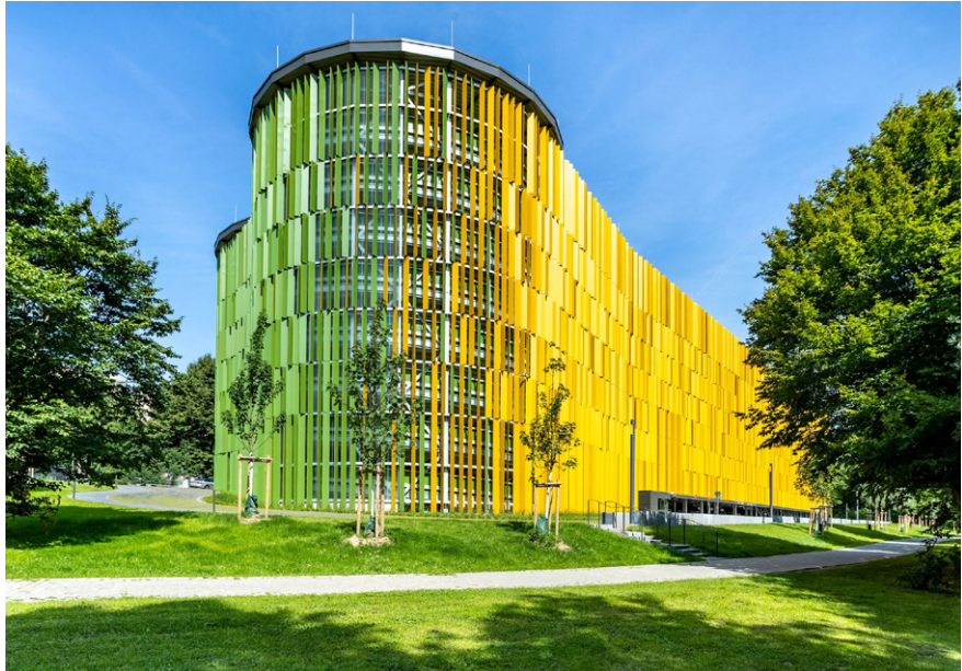
„Attraktiv, nachhaltig und nutzerfreundlich“ ist das gerade fertiggestellte Parkhaus am Universitätsklinikum in Aachen nach den Worten von HIB Huber Integral Bau.
